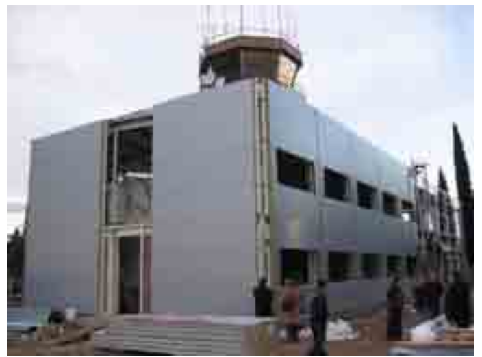
Слика 28. Реконструкција и надоградња објекта ТКЛ Подгорица
