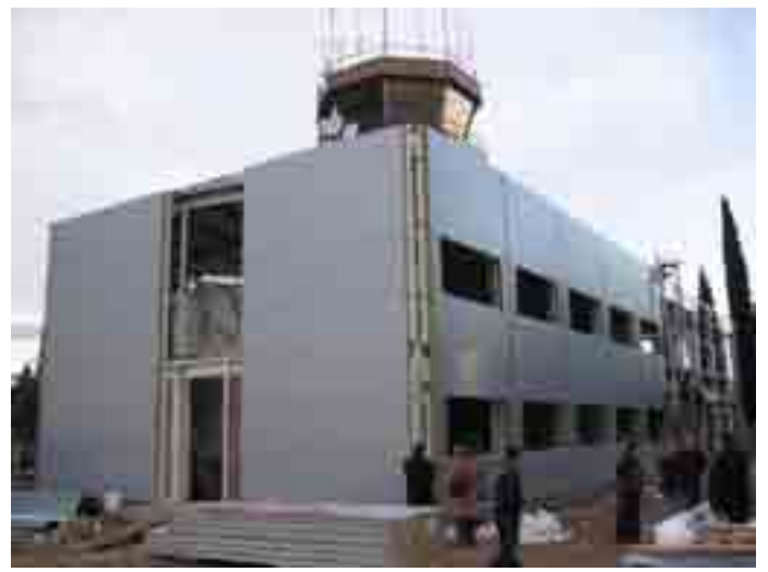
Слика 28. Реконструкција и надоградња објекта ТКЛ Подгорица
